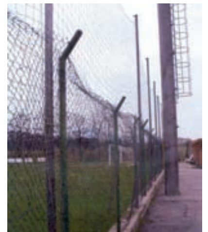
◀ Sostituzione dei pali alti 2,5 mt.
