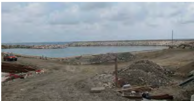
► I lavori di costruzione in fase di realizzazione
