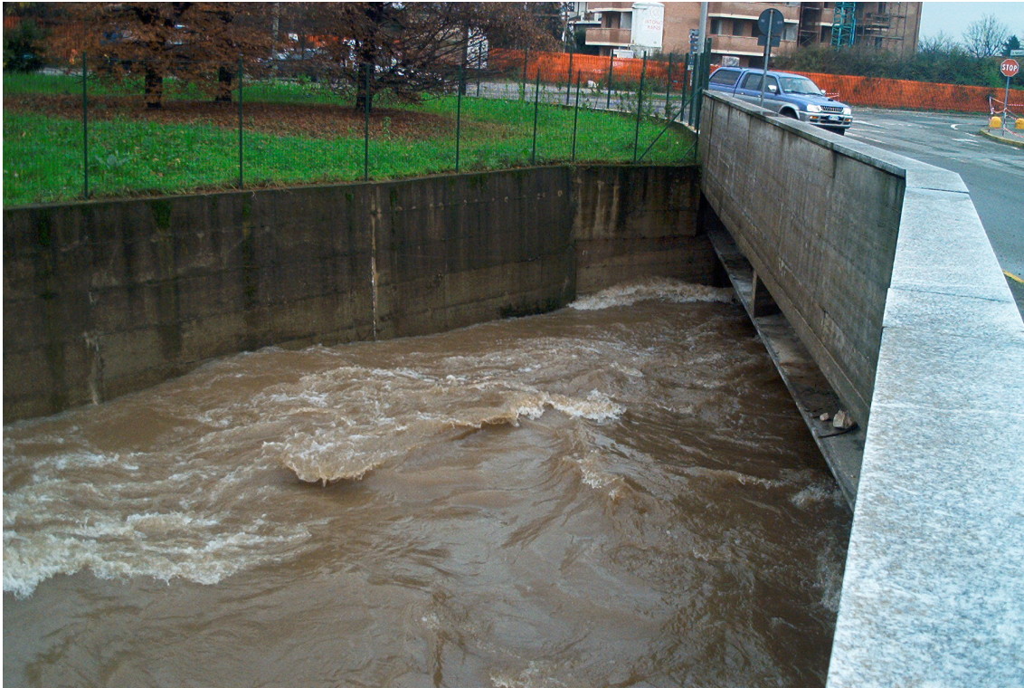
Fig. 9 - Ponte sul Seveso di Via Matteotti (Evento meteorico del 25 novembre 2002)
