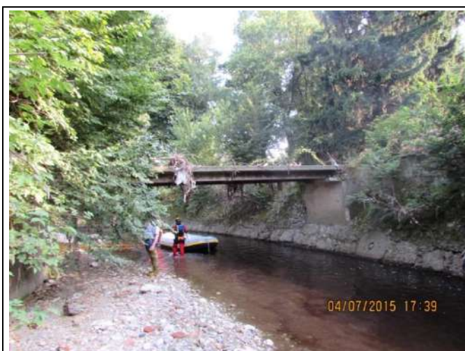
Foto 9 – Passerella villa Zari
