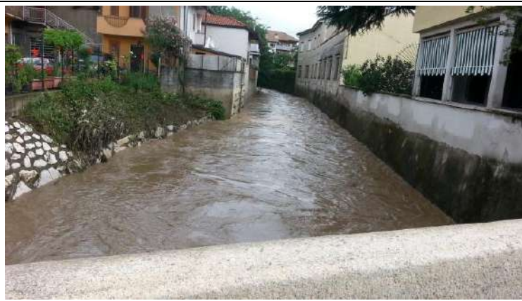
Foto 7 – Tratto a monte del Ponte su via Marconi
