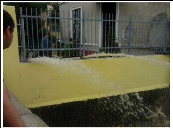
Foto 8 – Intervento di prosciugamento immobile a valle del Ponte di via Marconi in sx idrografica
