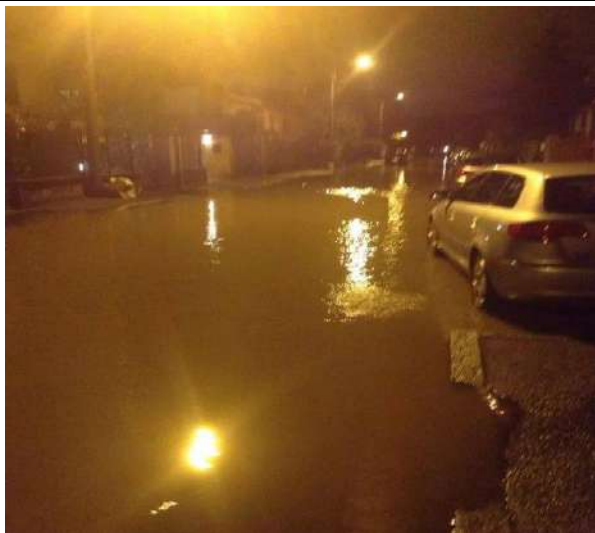
Foto 21 – Allagamento in via San Pancrazio
