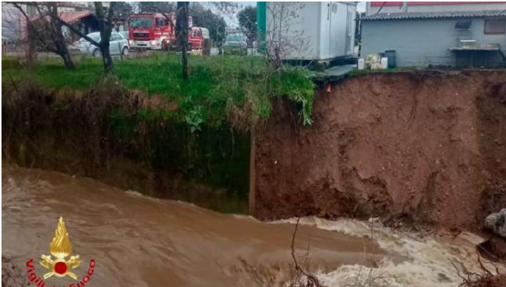
Foto 28 – Cedimento dell'argine sinistro del T. Seveso in prossimità di via Bottego (fonte: ilsaronno.it)
