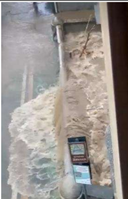
Foto 29 – Esondazione del T. Seveso che ha interessato il ponte di via Marconi (fonte: primamonza.it)
