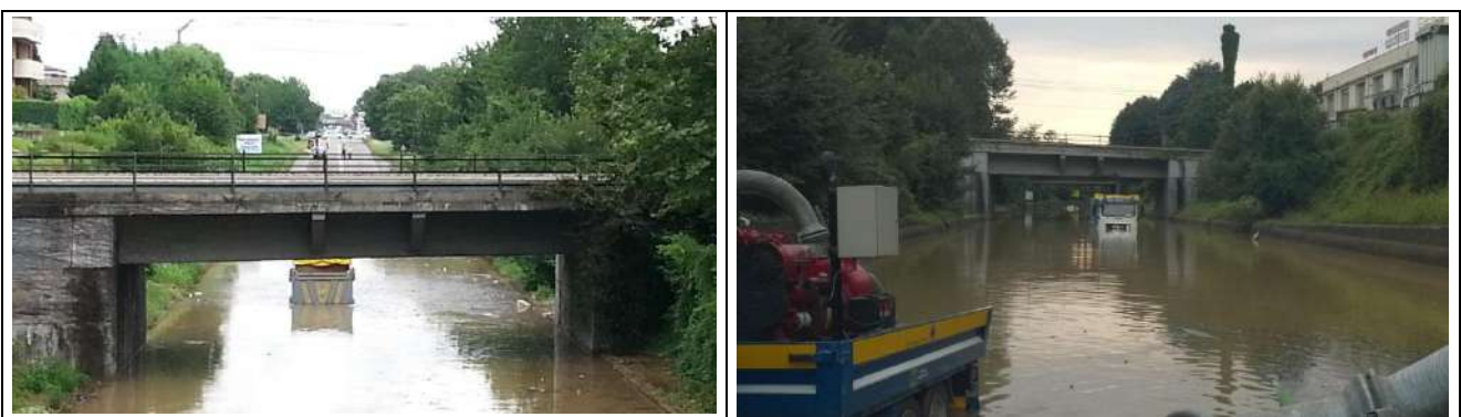
Foto 25 e Foto 26 – L'allagamento della SP 527 Monza-Saronno
