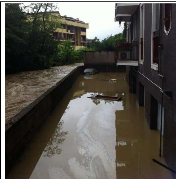
Foto 15 – Allagamento autorimesse edificio lato monte del Ponte di via Isonzo, in sx idrografica
