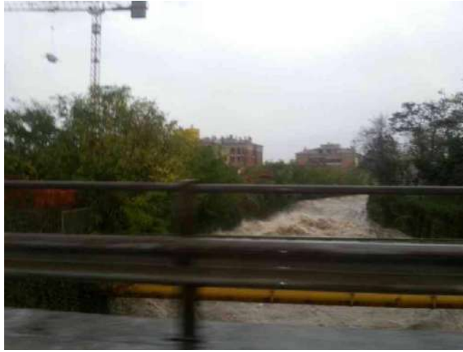
Foto 27 – Il Ponte sulla SP 527 durante l'evento dell'8 luglio 2014
