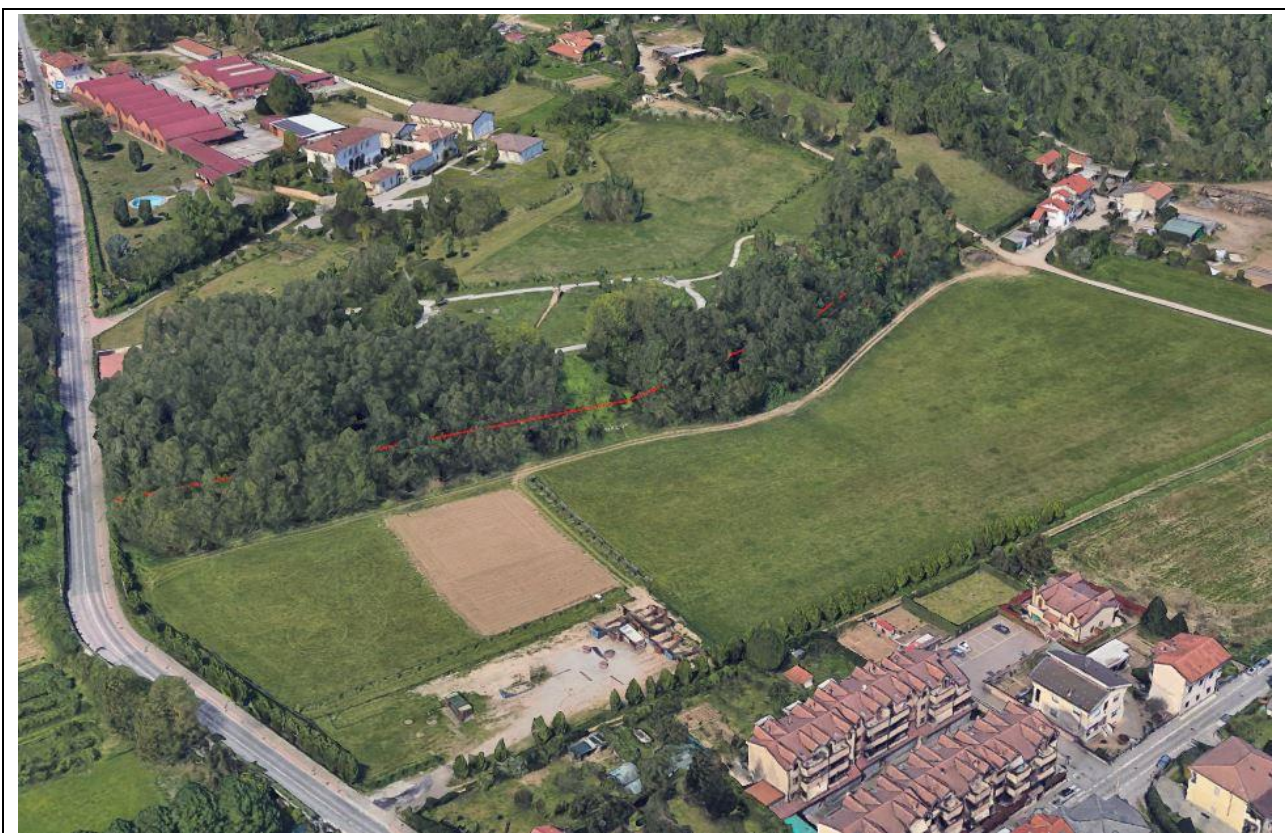
Fig. 6 – Area di scarpata (rappresentata dalla linea rossa) in prossimità della loc. "Villa Biffi"
