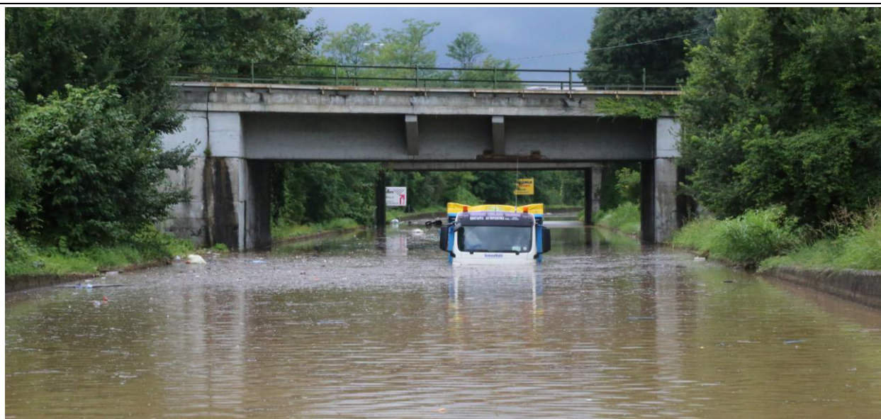
Foto 4 - Esondazione del luglio 2014 del Torrente Seveso nel Comune di Bovisio Masciago
