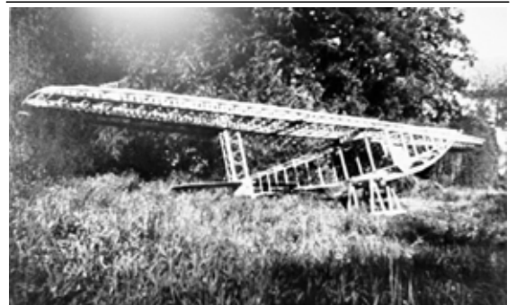
La struttura dell'aliante G.P.1 prima dell'applicazione del rivestimento
