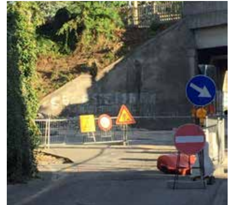
Cantiere rotonda via 4 Novembre
