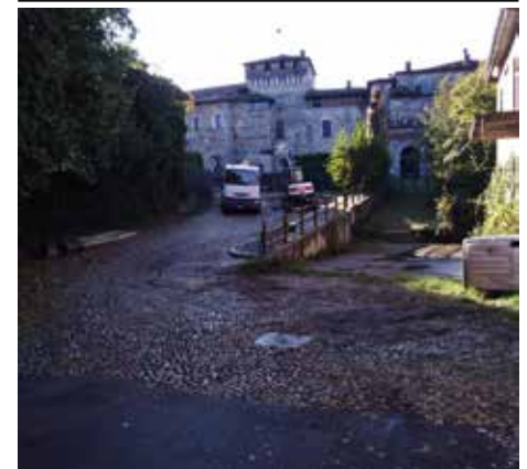
Cantiere pavimentazione via Sfondrati
