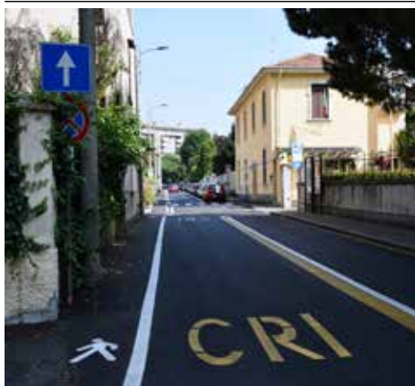
Asfaltatura in via Bellini
