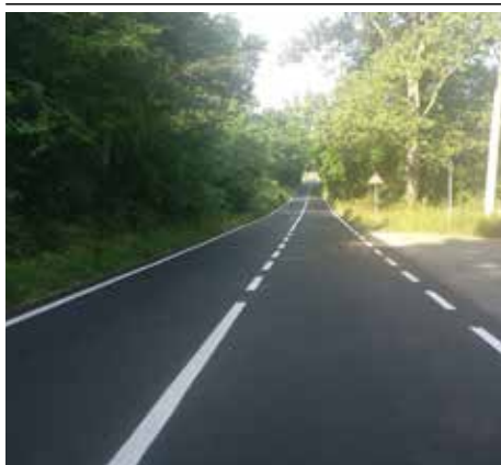
Via per Coarezza con asfalto nuovo
