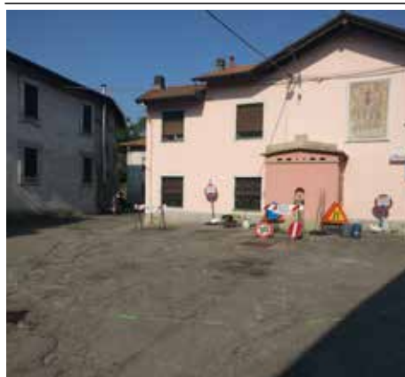
Lavori in corso in piazza Matteotti (Coarezza)
