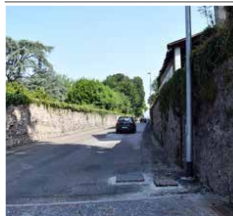
Asfaltatura in corso in via Mazzini
