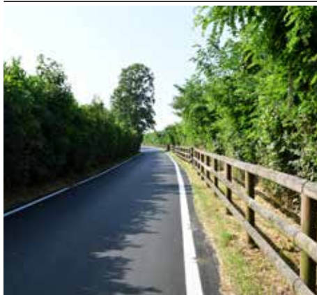
Asfaltatura via Isaia Bianco
