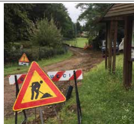
Il cantiere nell'ex via Molino Secco
