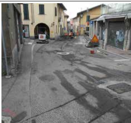
I lavori di asfaltatura in via Briante
