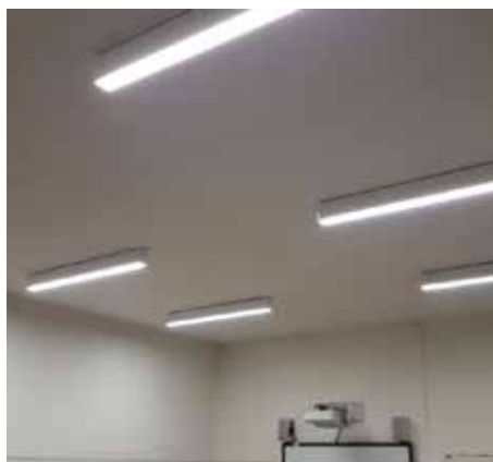
Relamping nelle scuole: sostituzione completa dell'impianto di illuminazione con nuove lampade a led
