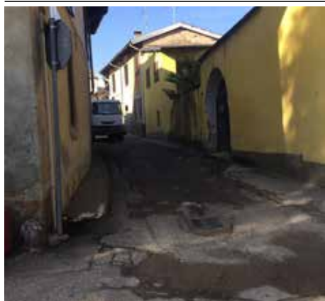
Asfaltatura in via Vira
