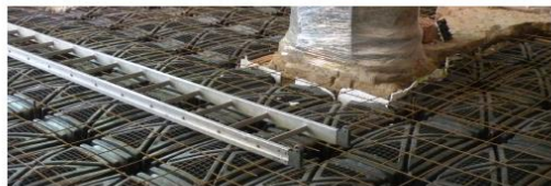
dalla muratura umida.
