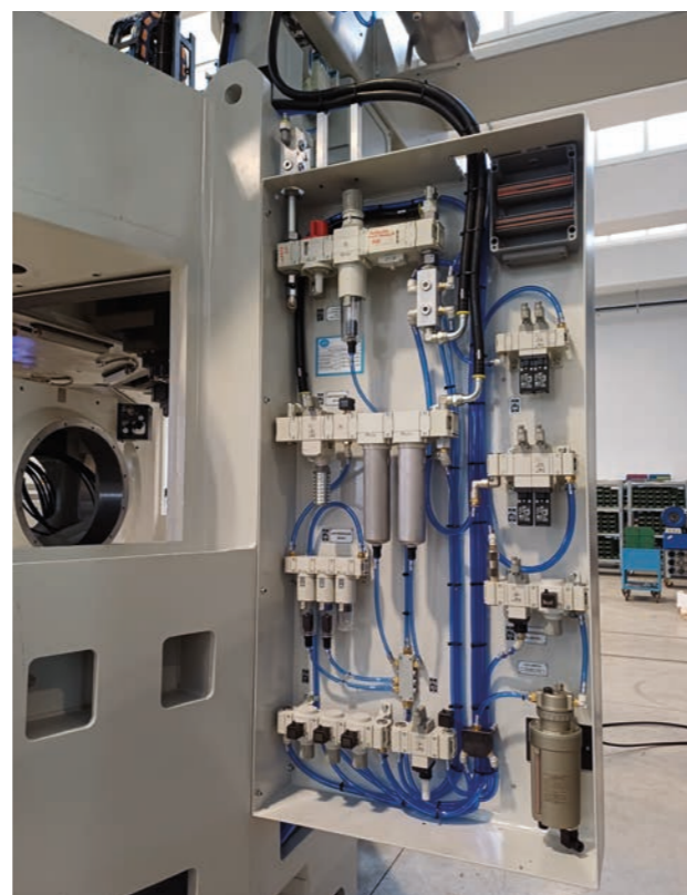
Tutte le utenze sono installate a bordo macchina
