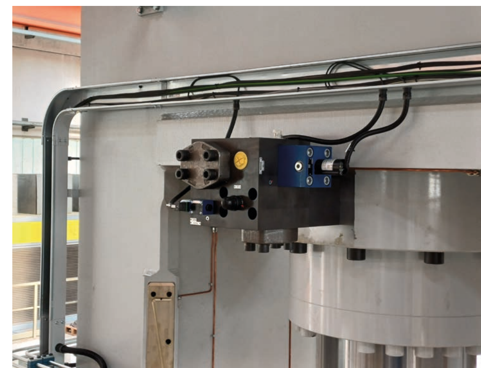
Sistema di sicurezza anticaduta che agisce sulla camera anulare inferiore
